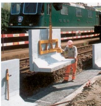
Mise en place des éléments sans couche de mortier d'égalisation.
