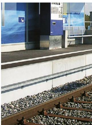
**Assemblage marchepied en béton type 12**
