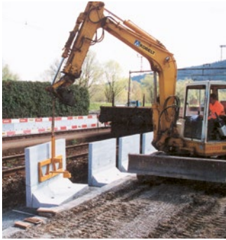
Transport der Elemente ohne Mithilfe zusätzlicher Arbeitskräfte
