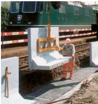
Einbau der Elemente ohne Mörtelausgleichsschicht
